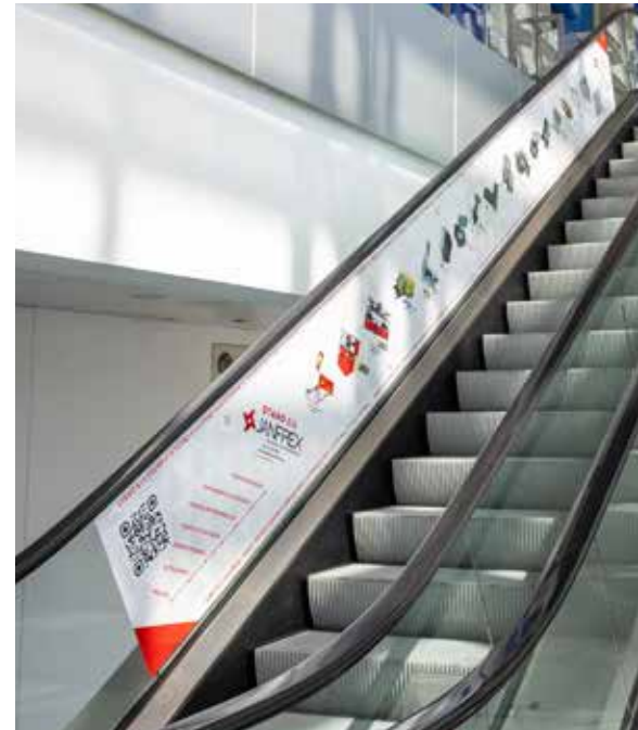
Escaleras eléctricas (Barandales)
